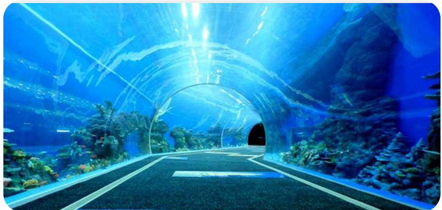
Providni podvodni tunel od PMMA izgrađen u kineskom akvaparku
