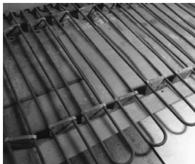
Slika 12. Električni grejači za zagrevanje ploče
